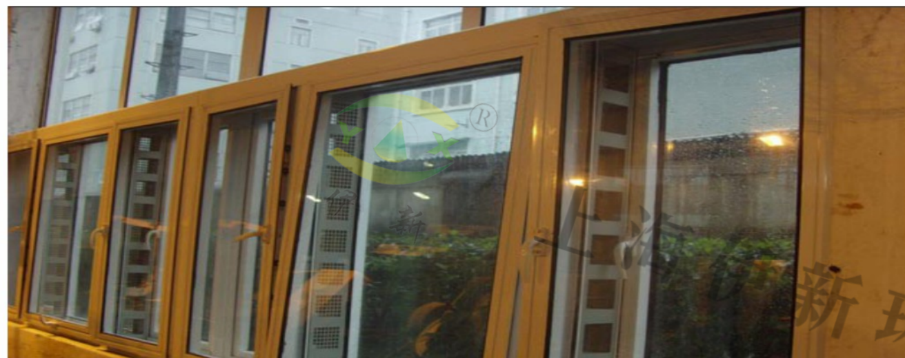
上海一胜百有限公司磨具车间噪声治理(通风隔声窗)改造工程
