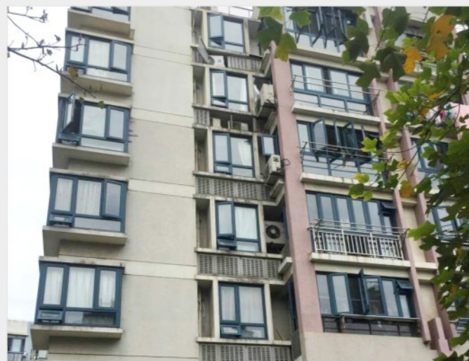
上海浦东中环线噪声治理(隔声窗)改造工程
