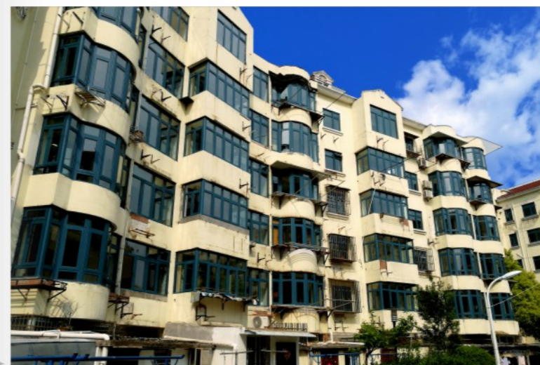
浦东中环线噪声治理金杨路985弄小区(隔声窗)改造工程
