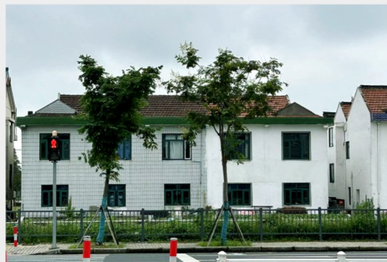
平申线金山段金枫大桥噪声治理(隔声窗)改造工程
