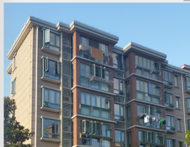
上海浦东林海公路噪声治理(通风隔声窗)工程
