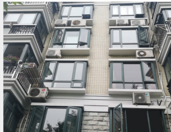
上海中环线噪声治理浦西段(通风隔声窗)改造工程
