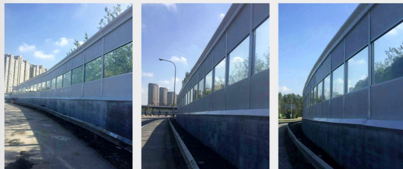
上海S4悦达南郊小区声屏障工程
