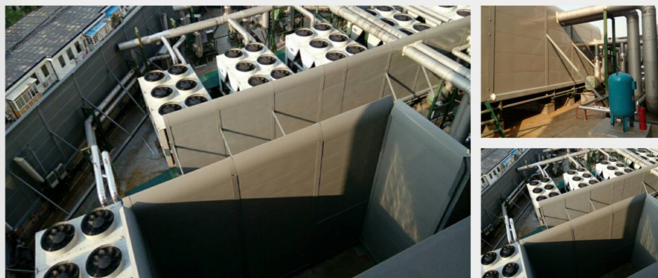
民主党派大楼空调设备降噪项目
