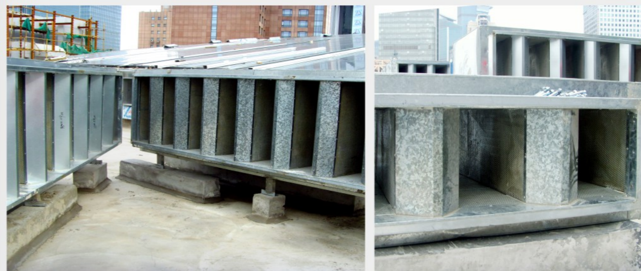
上海静安寺交通枢纽屋顶通风设备降噪工程
