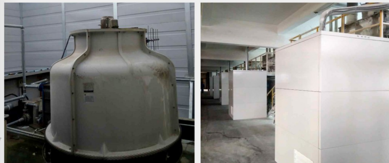
上海凯波电缆厂设备综合降噪工程
