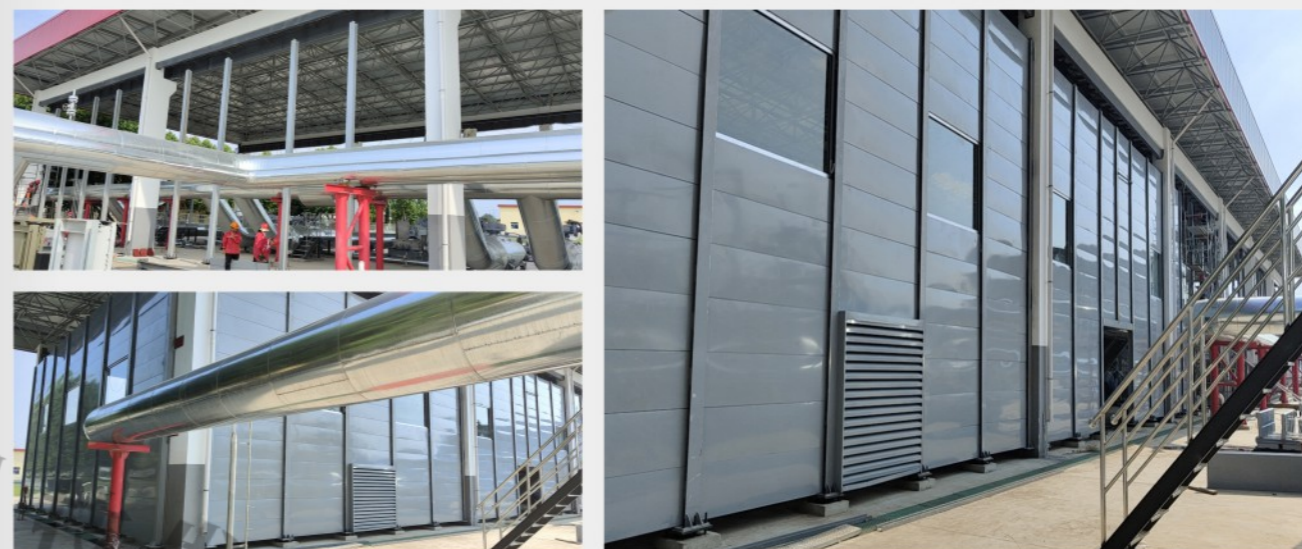
河南濮阳市柳屯镇输油站(中国石化)降噪工程
