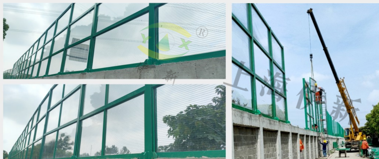
沪宁高速昆山段茗景苑小区声屏障工程
