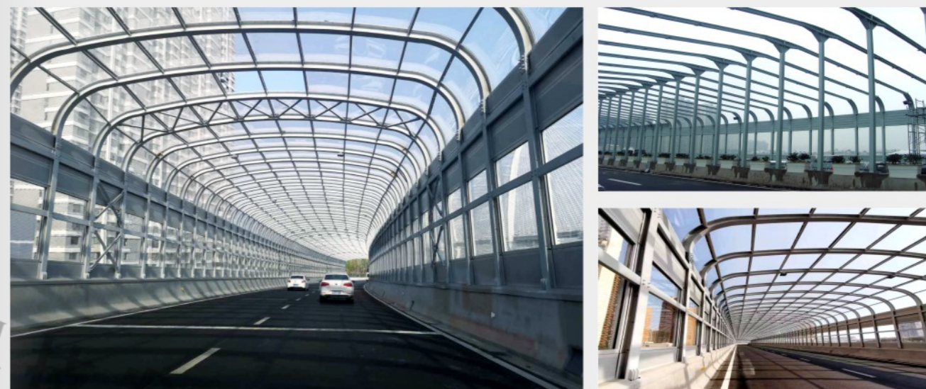
武汉市光谷大道全封闭声屏障工程
