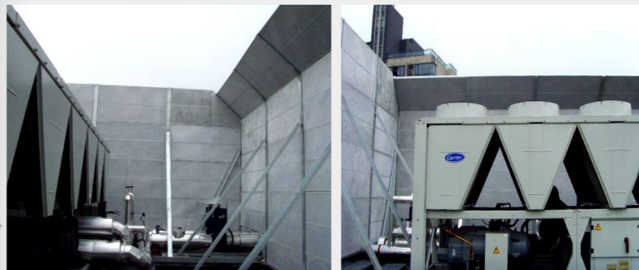
浦东万得城商业广场空调设备降噪工程
