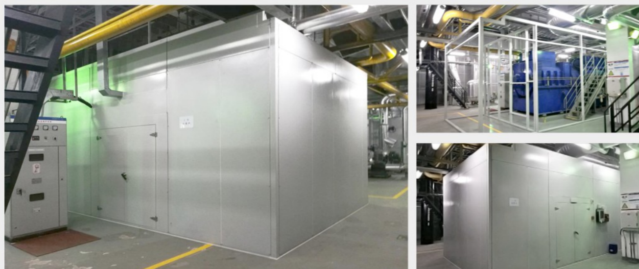
上海世博B片区央企总部能源中心燃气内燃发电机组隔声罩降噪工程
