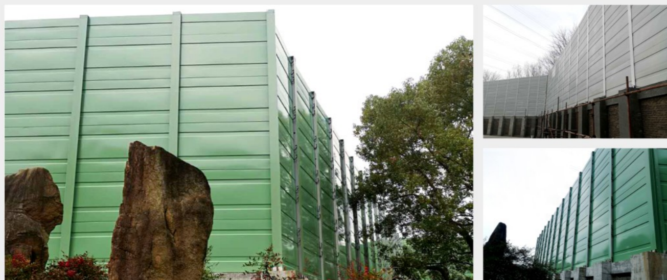
上海轨道交通市域线机场联络线施工设备降噪工程
