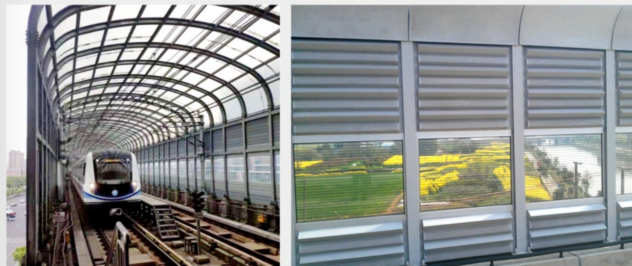
上海地铁8号线浦江段声屏障工程
