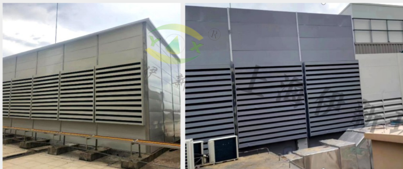
大润发晋江店屋顶设备降噪工程
